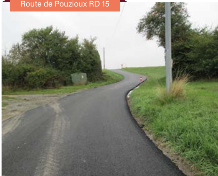
Route de Pouzioux RD 15
