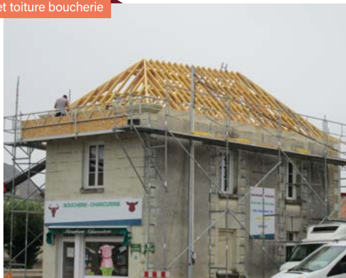
Nouvelle charpente et toiture boucherie
